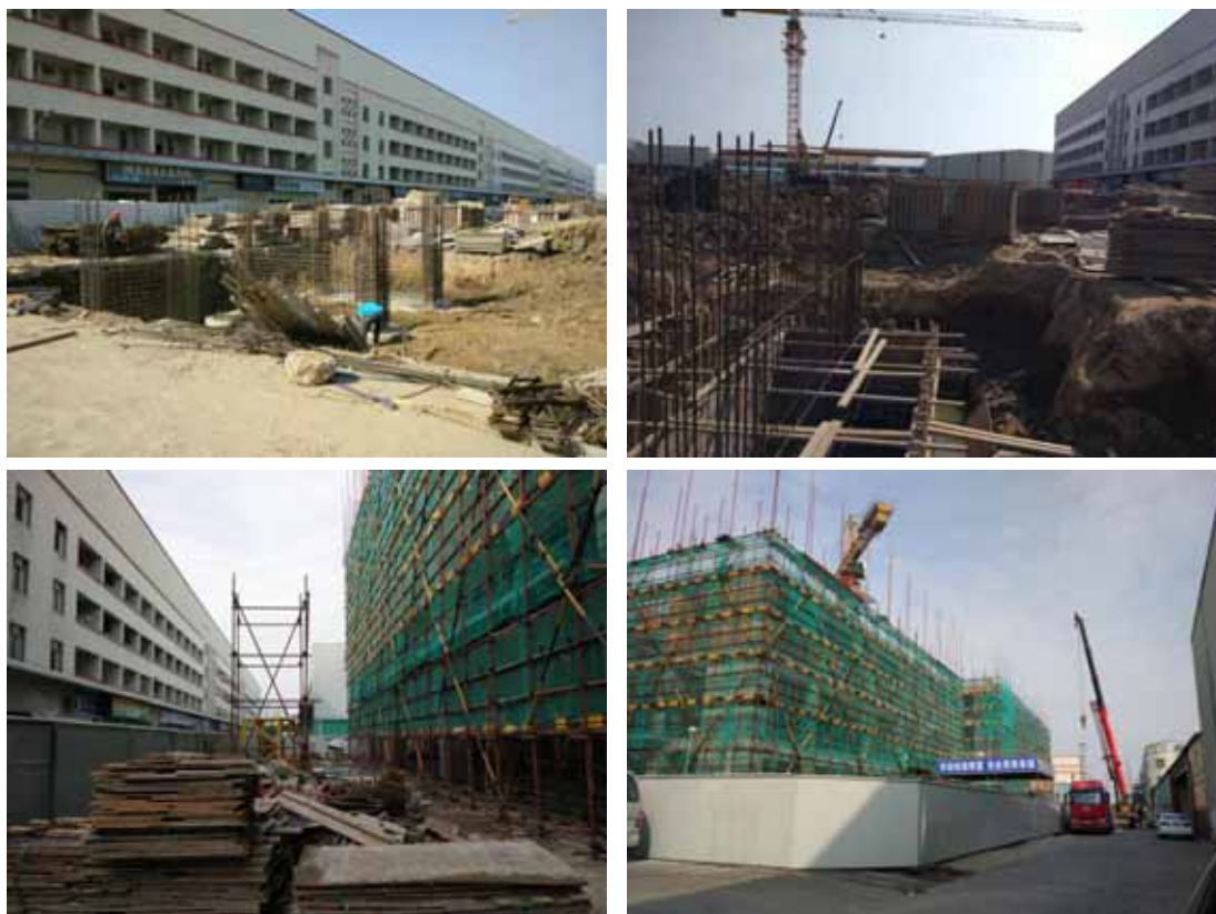
图 5-1 项目现场施工情况
